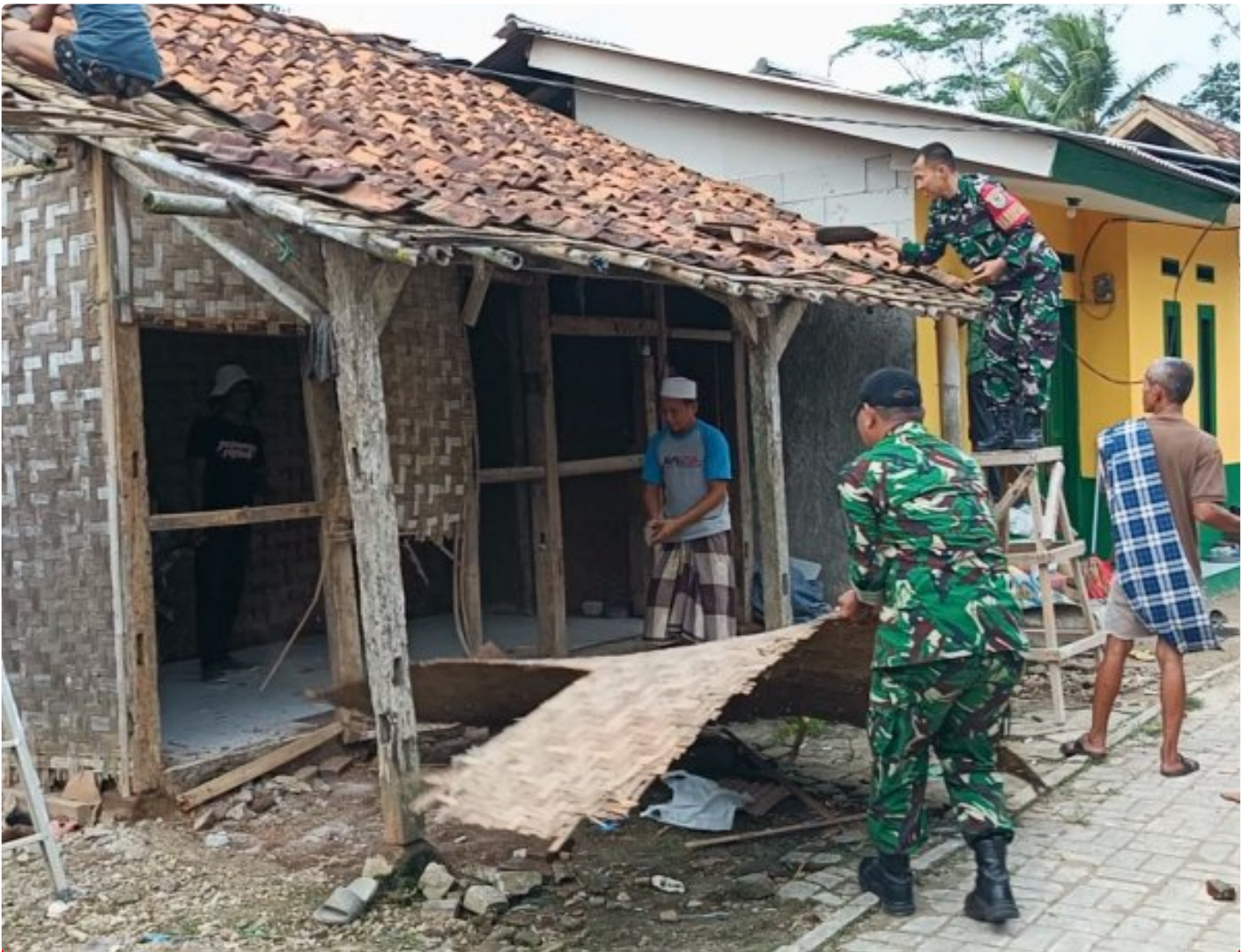
Pembongkaran Rumah Bapak Narmin
